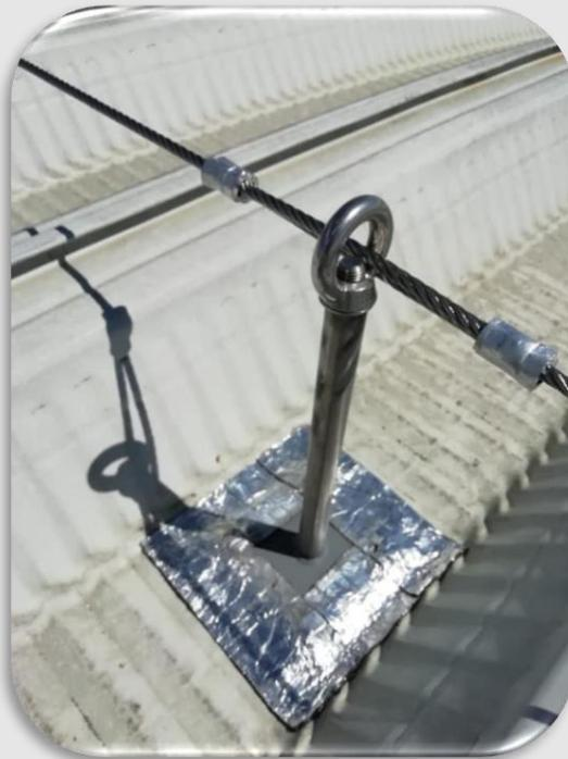
Especiales para proteger a los trabajadores mientras realizan trabajos de mantenimiento de las cubiertas.
